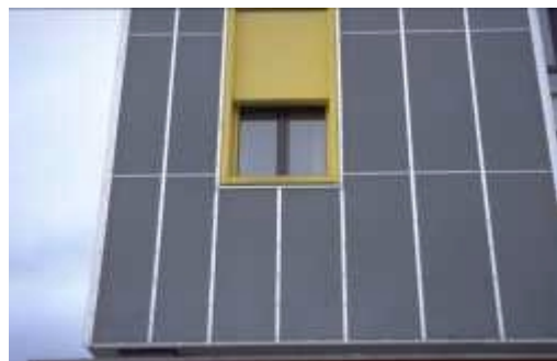
Bild 1: Detailaufnahme der Südfassade des Kolpingheims, Dornbirn
