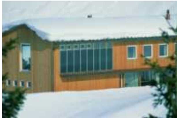
Bild 2: Fassadenintegrierte Kollektoren, Arlberg
