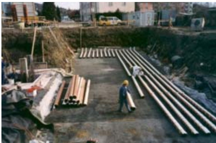
Abbildung 5: Verlegung der 15 parallelen PVC-Rohre unter der Fundamentplatte des Gebäudes
