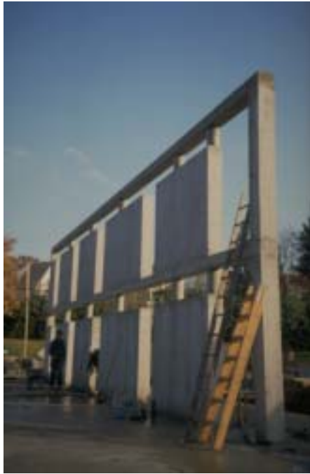
Abbildung 3: 30 cm starke Innenwand aus Stahlbeton als Speichermasse
