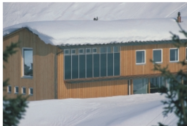
Abbildung 4.6: Fassadenkollektoranlage, Arlberg, Foto: DOMA Solartechnik
