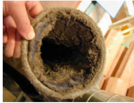
Abbildung 13: Verschmutzte Ventilfilter in Taschenfilterausführung
