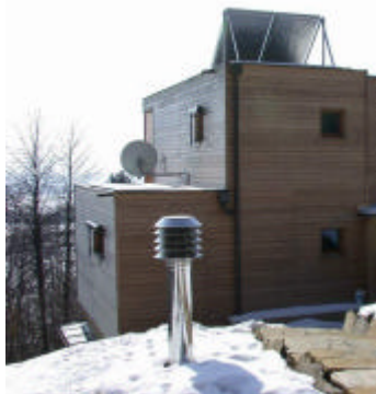
Abbildung 6: Frischluftansaugung mit freistehendem Lamellenhut mit Ringfilter G4
