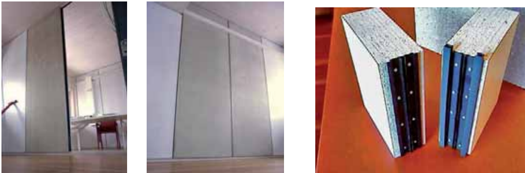
Abbildung 54: Flexible Trennwände aus Naturfaser-Compounds, S-HOUSE.
