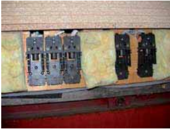
Abbildung 72: Deckenmontage bei Testhäusern mit Schnellverbindern. Aus Prochiner (2006): S. 230.
