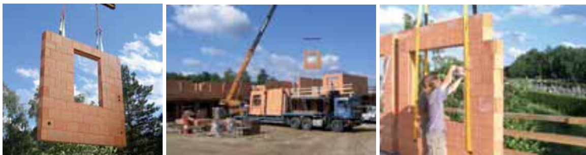
Abbildung 17: Aufbau der vorgefertigten Wandelemente von Redbloc.
