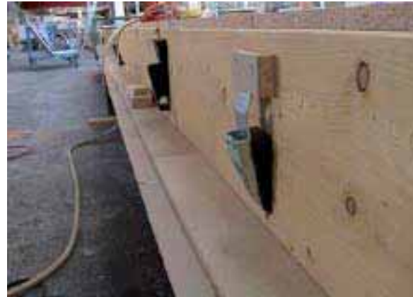
Abbildung 72: Deckenmontage bei Testhäusern mit Schnellverbindern. Aus Prochiner (2006): S. 230.
