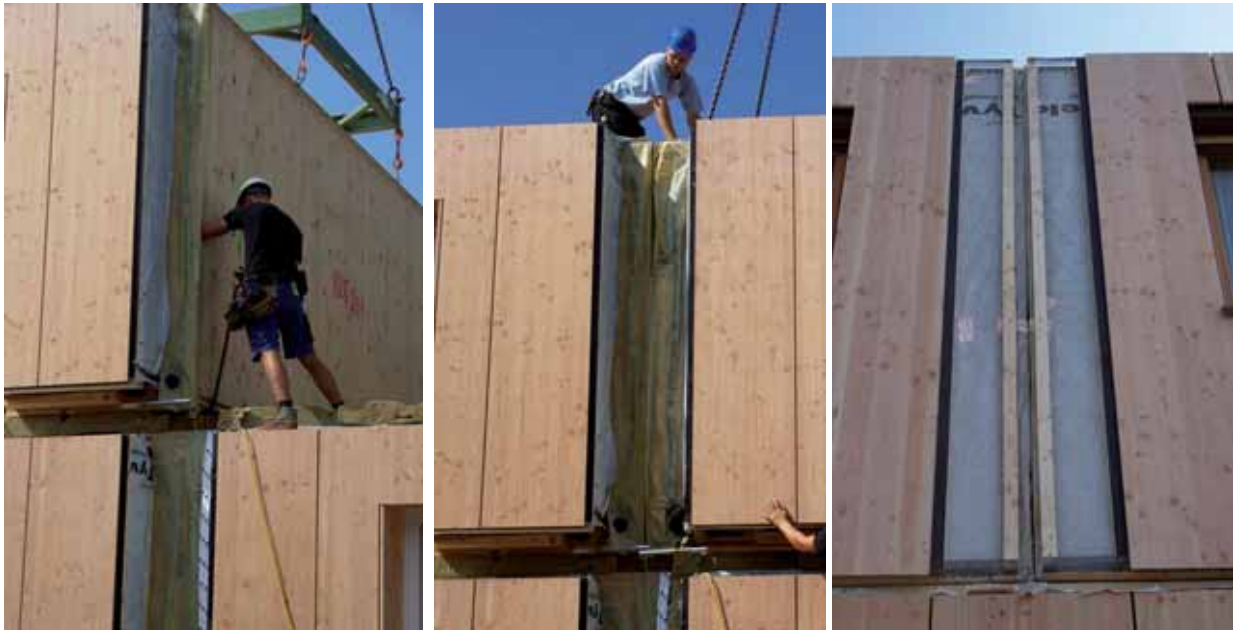
Abbildung 51: Verbindung von zwei Raumzellen, Schaumontage Modulfabrik, Gästehaus Aquilin, St. Pölten.
