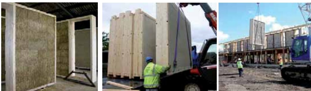
Abbildung 35: Module verlassen die Flying Factory.
