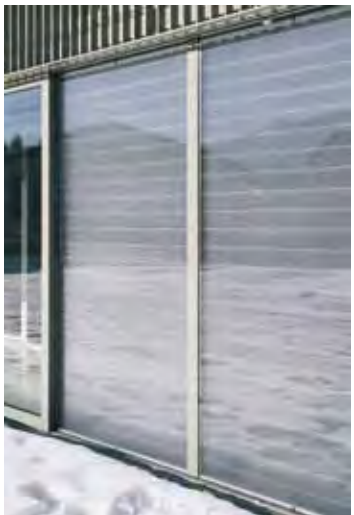
Alterswohnanlage Domat/Ems: Außen- und Innenansicht der Fassade mit GlassXcrystal-Latentspeicherwand. Fotos: Gaston Wicky
