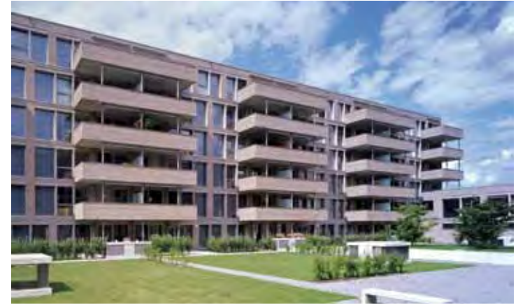
Nullenergiebau Eulachhof, Oberwinterthur: konsequente Ausnutzung der solaren Strahlung an der Südfassade mit einer Latentspeicherwand (GlassXcrystal). Foto: Huberlendorff
