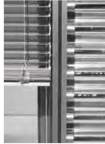
Fassadenintegrierte Röhrenkollektoren, entwickelt vom Institut für Baukonstruktion L2 der Universität Stuttgart. Fotos: UNI Stuttgart IBK 2
