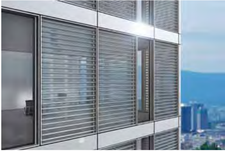
Fassadenintegrierte Röhrenkollektoren, entwickelt vom Institut für Baukonstruktion L2 der Universität Stuttgart. Fotos: UNI Stuttgart IBK 2
