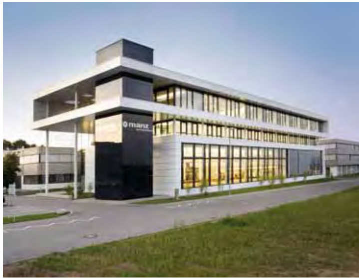
CIS-Dünnschicht-Fassadenmodule StoVerotec Photovoltaic, Testobjekt: Manz Automation AG, Reutlingen/Deutschland, Architekt: Hank + Hirth Freie Architekten. Fotos: Oliver Starke
