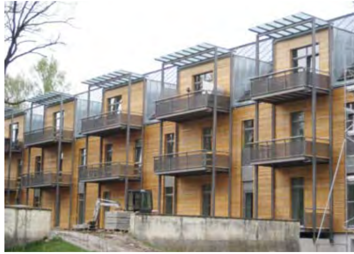
Siedlung Bad Aibling, Sanierung ehemaliger Militärbauten mit vorgefertigten Holzelementen zu Wohngebäuden. Foto: RK-Stuttgart Architekten
