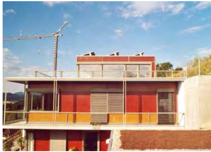
Lucido® Solar: realisierte Projekte mit solaraktiver Holzfassade in Will und Winterthur, Schweiz. Fotos: Lucido®
