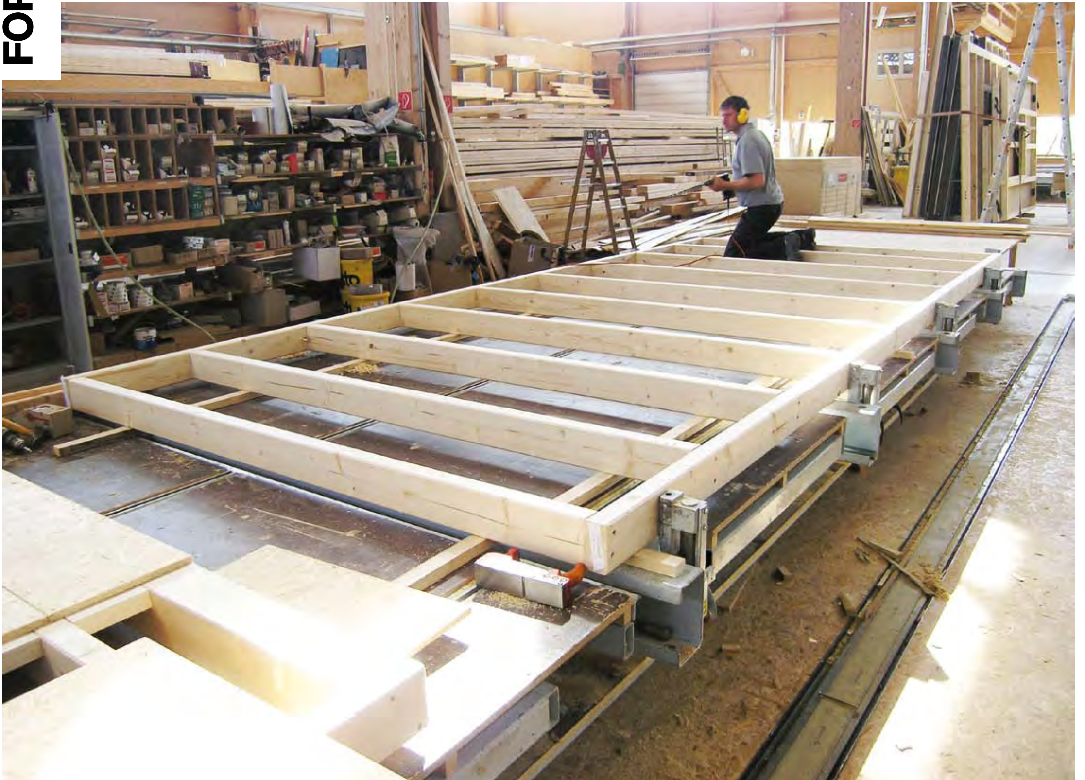
TES-EnergyFacade, Gebäudemodernisierung mit Holzbaulösungen: Fertigung der Holzfassadenmodule in der Werkhalle. Foto: Fachgebiet Holzbau, TU München
