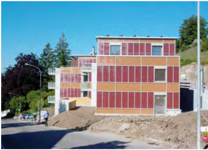
Lucido® Solar: realisierte Projekte mit solaraktiver Holzfassade in Will und Winterthur, Schweiz. Fotos: Lucido®
