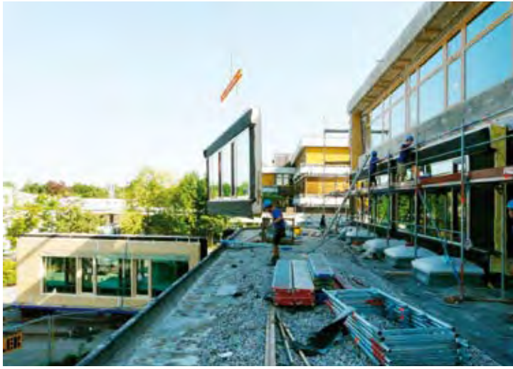
TES-EnergyFacade, Montage der vorgefertigten Holz-Fassadenmodule. Foto: Fachgebiet Holzbau, TU München
