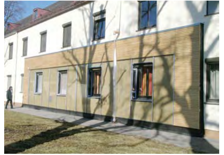
Aktive Gebäudehülle, Testfassade an modernisiertem Gebäude in Bad Aibling. Planung: Schankula Architekten. Foto: RK-Stuttgart Architekten
