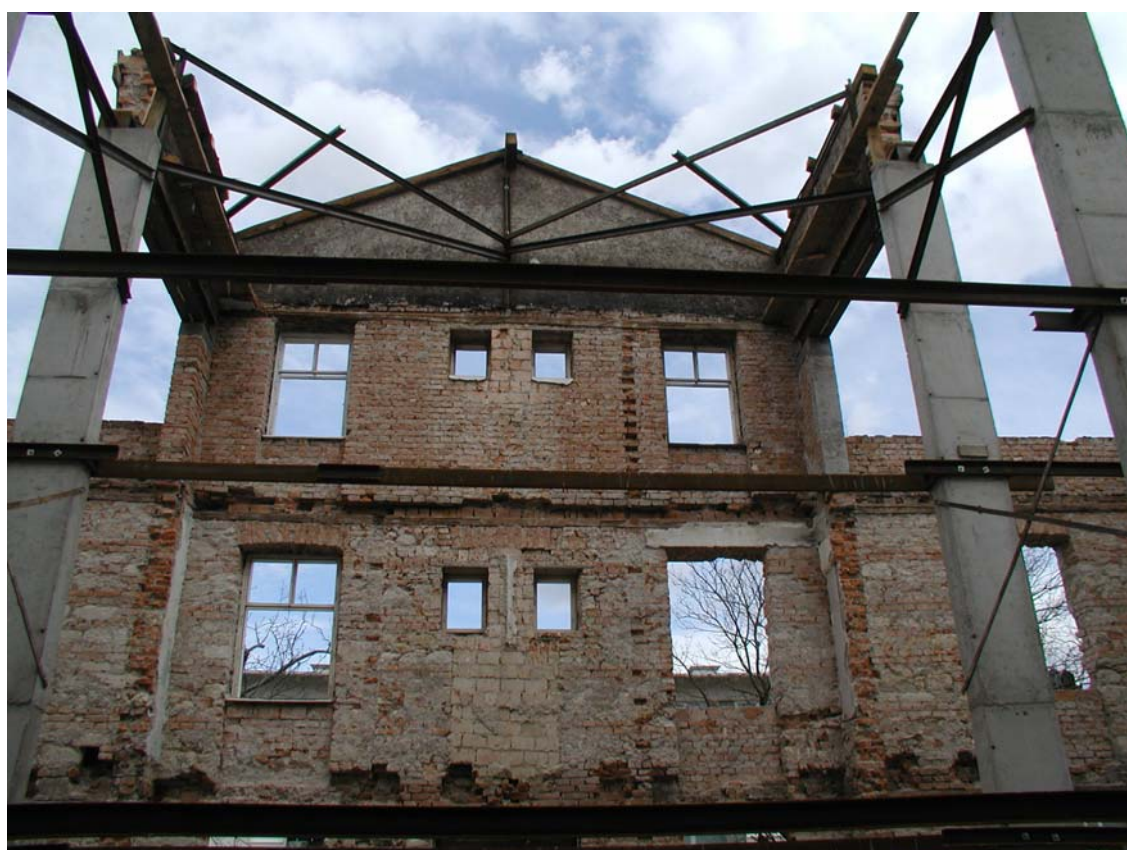
Abbrucharbeiten – Fassadenreste - Aussteifungsarbeiten
