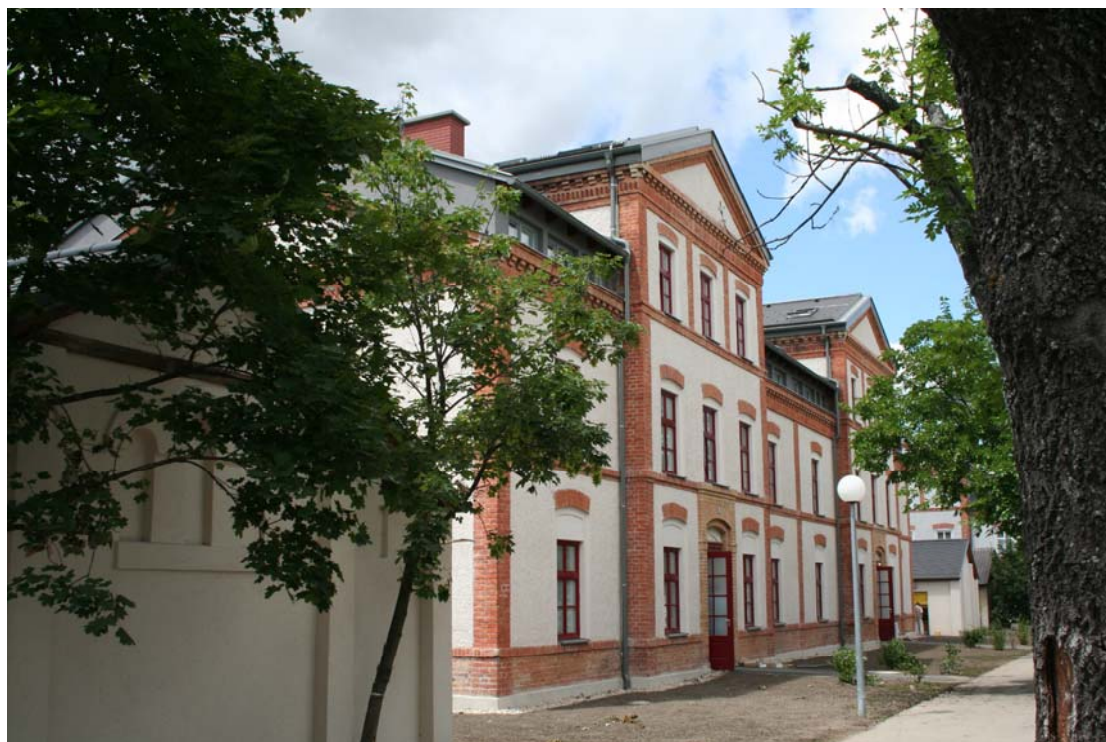
Saniertes Objekt Block A
