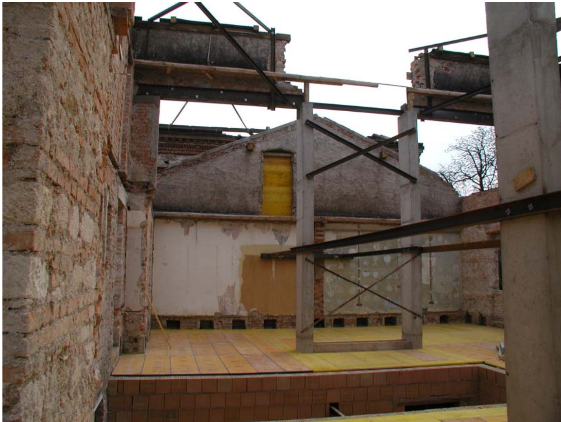
Schalungsarbeiten Decke und EG
