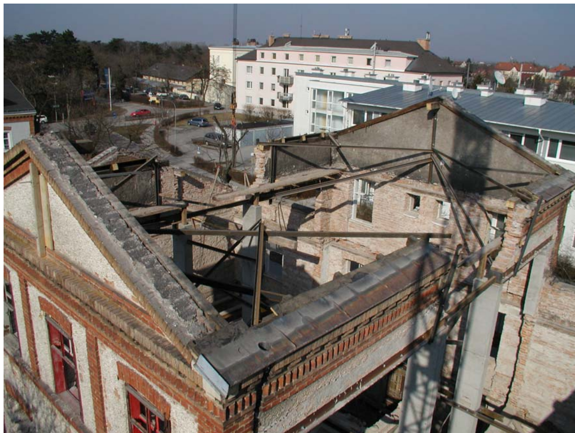
Abbrucharbeiten – Fassadenreste - Aussteifungsarbeiten
