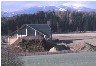
Source: The Tamsweg DH plant
