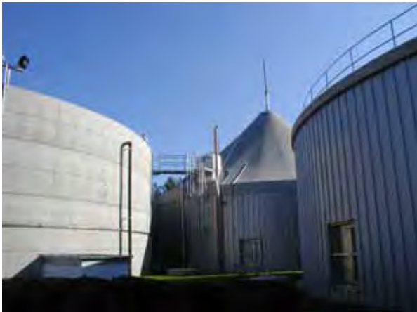
Abbildung 4: Hauptfermenter (rechts), Nachfermenter inklusive Gaslager (Mitte) und Endlager (links) [Puchas, LEA Oststeiermark]
