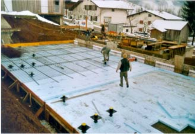
Bodenplatte mit Dämmung
