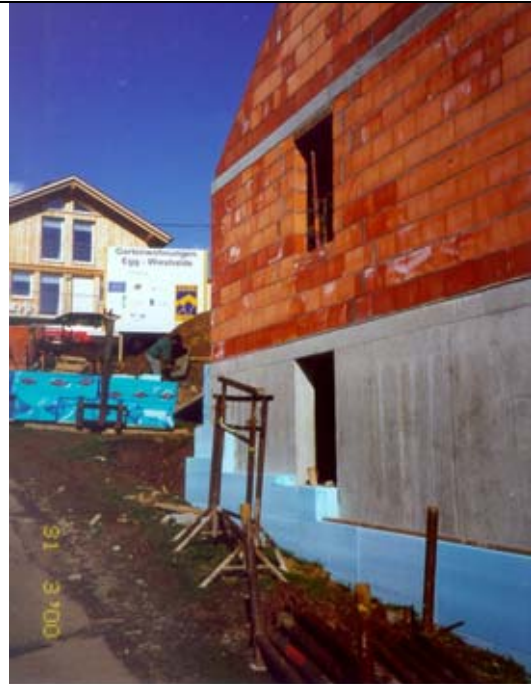
Rohbau mit Perimeterdämmung
