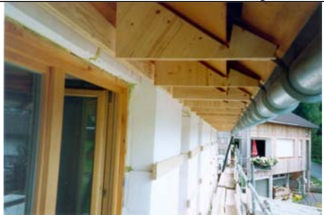
Bereits aufgeklebte Lattung für die Montage des Holzschirms
