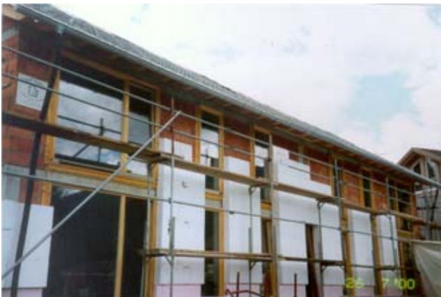
Aufkleben der Außendämmung
