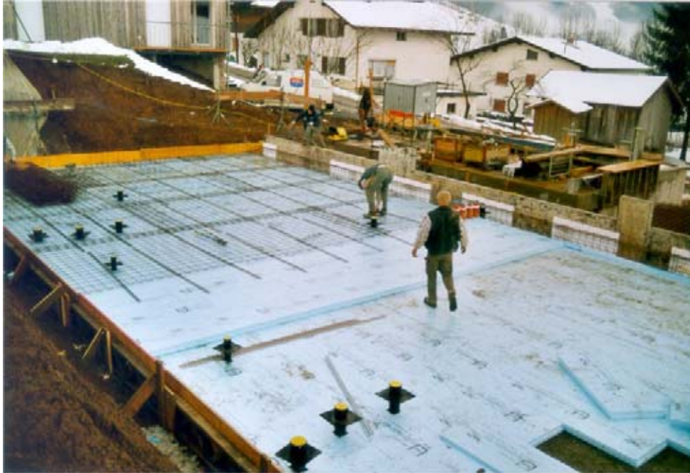
Abbildung 29: Dämmung unterhalb der Bodenplatte mit 16 cm extrudiertem Polystyrol
