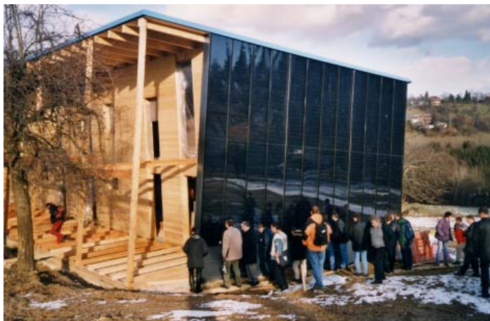
Abbildung 2: Testfassade mit 55 m 2 Kollektorfläche auf einem Zweifamilienwohnhaus in Graz
