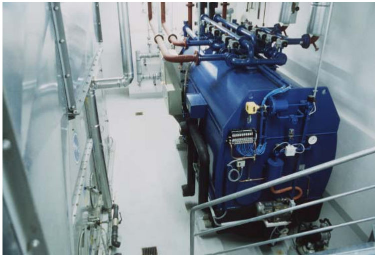
Abbildung 1: Adsorptionskältemaschine GBU NAK, Nennkälteleistung 70 kW
