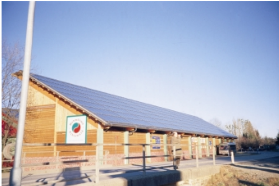
Abb. 1: Ansicht des solarunterstützten Biomasse-Nahwärmenetzes Eibiswald.
