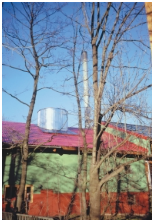
Abb.3: Der Pufferspeicher mit einem Volumen von 105 \text{ m}^3 ragt aus dem Dach des Heizhauses
