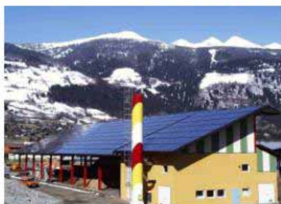
Abb. 10a: Solaranlagen zur Warmwasserbereitung in Mehrfamilien-Wohnhäusern und zur Unterstützung kommunaler Biomasse-Wärmenetze
