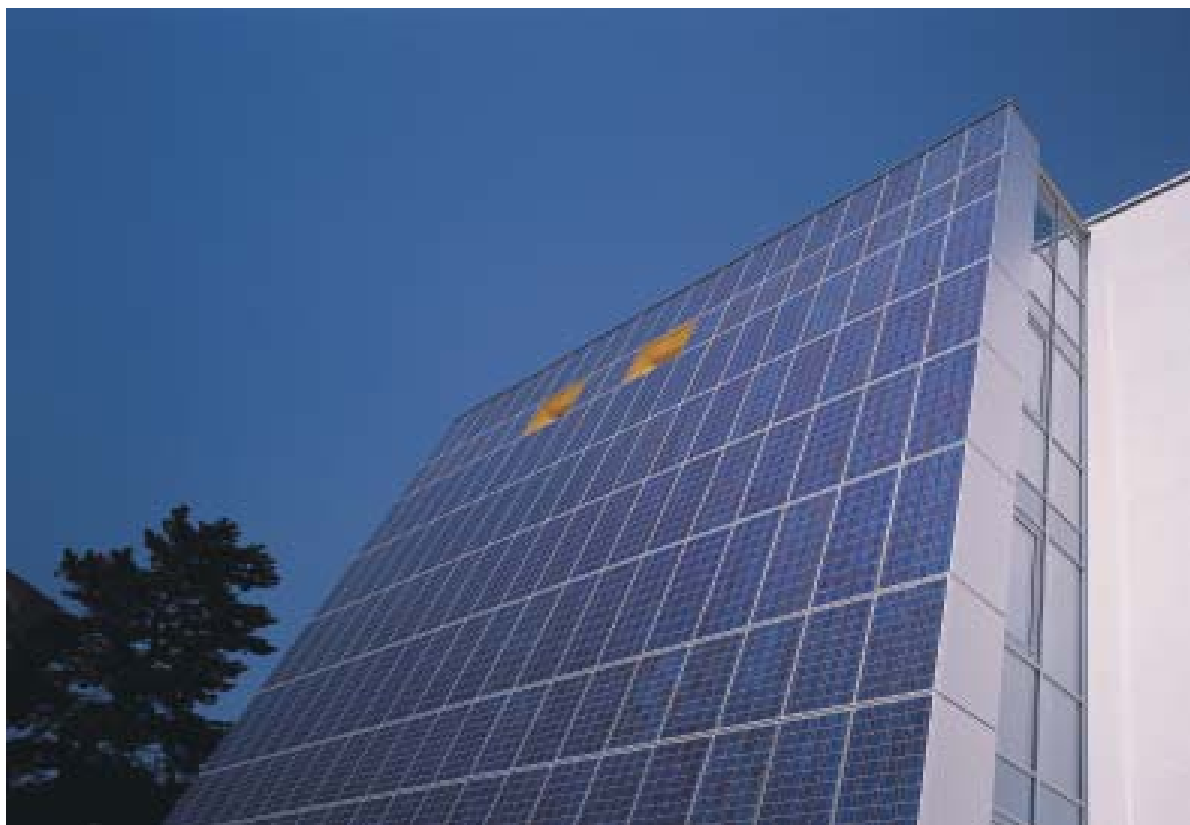
Abbildung 3: Der Sonnenpark in Dornbirn, Planung: Arch. Büro MHM - Dornbirn, DI Arch. Michael Heim, DI Arch. Herbert Müller, Ausgezeichnet mit dem Österreichischen Solarpreis 1999. 18,08 kWp aus 197 PV-Paneeelen
