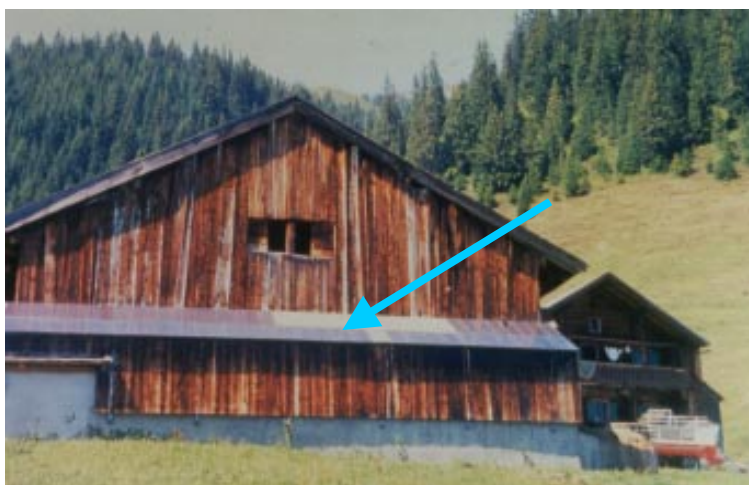
Abb. 1: Gebäudeintegrierte 2 kW-Photovoltaikanlage im Inselbetrieb. Baumgartalm in Salzburg
