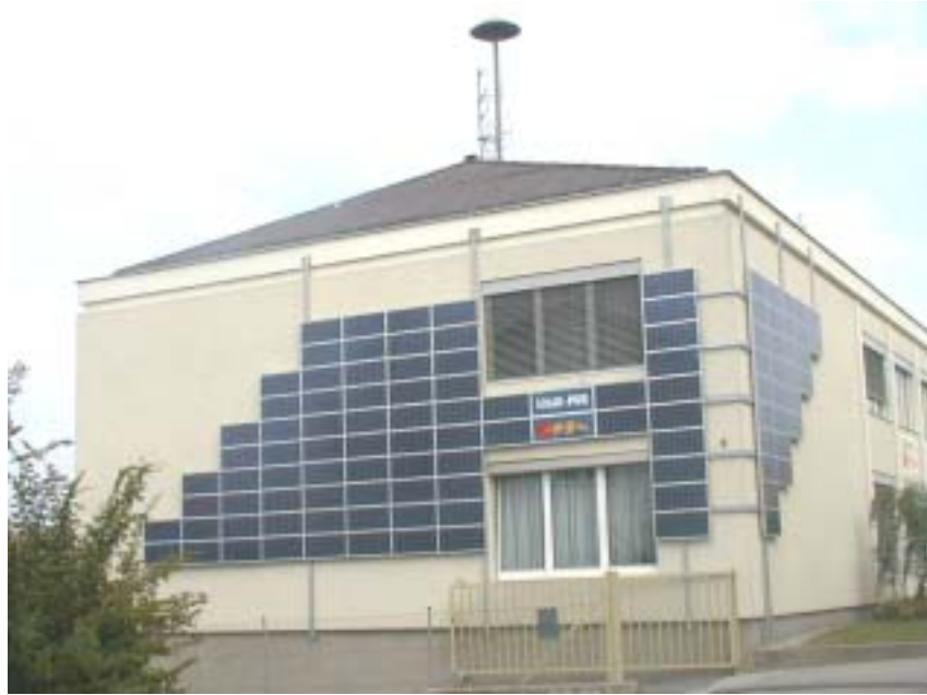
Fassaden Sonnenkraftwerk am Betriebsgebäude der Feistritzwerke Steveag
