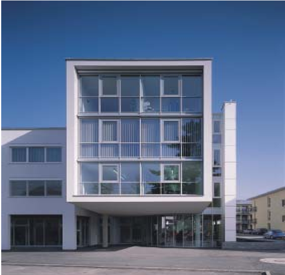
Abbildung 4: Sonnenpark in Dornbirn, Großzügige Öffnungen an der West- und Ostseite des Gebäudes zur Belichtung der Büroräume
