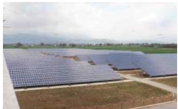
Abbildung 7: 3,3 MW Anlage Serre mit zentralen Wechselrichtern
