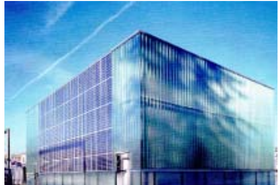
Abbildung 1: 11,7 kW fassadenintegrierte Anlage Umspannwerk Rieden
