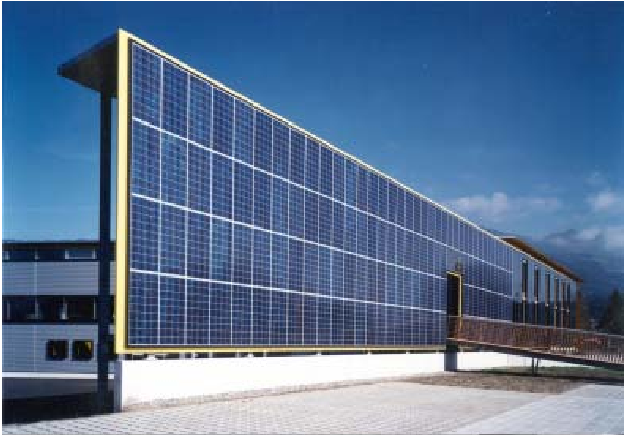
Abbildung 5: Der Energiepark West in Satteins, Planung: Arch.büro MHM - Dornbirn, DI Arch. Michael Heim, DI Arch. Herbert Müller, Ausgezeichnet mit dem Österreichischen Solarpreis und dem Eurosolarpreis 2000. Energiefassade mit 220 m 2 Solarpaneele – 17,16 kWp bzw. 10,17 kWh
