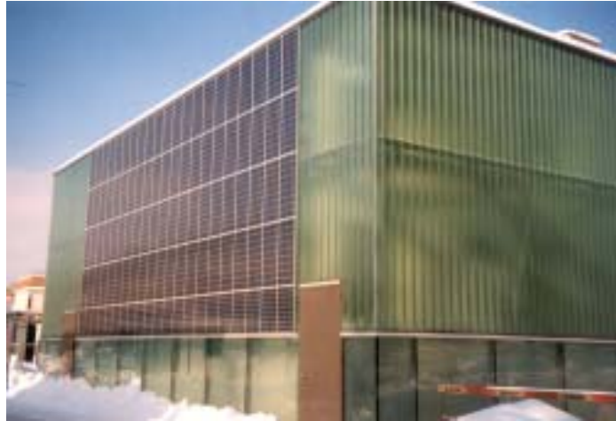
Abbildung 2: Neubau, Fassadenintegration einer Photovoltaik Anlage
