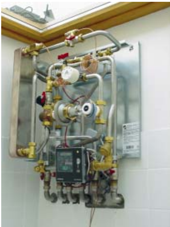
Abbildung 2: Vorinstallierte Wärmeübergabestation mit externem Wärmetaucher zur Brauchwasserwärmung und sämtlichen Komponenten für den Heizbetrieb inkl. Wärmemengenzähler (Produkt: Gemina-Termix, (Photo GSWB, Salzburg))
