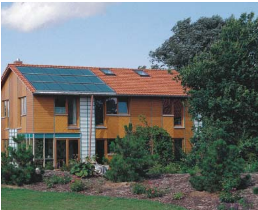
Abb.6: Die Kollektorflächen von Kombianlagen lassen sich ideal in Dächer oder auch Fassaden integrieren.
