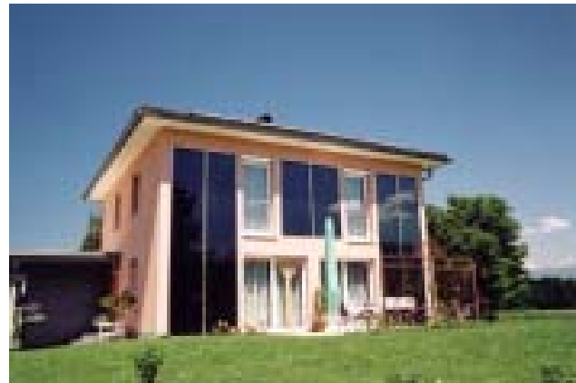
Abb.6: Die Kollektorflächen von Kombianlagen lassen sich ideal in Dächer oder auch Fassaden integrieren.
