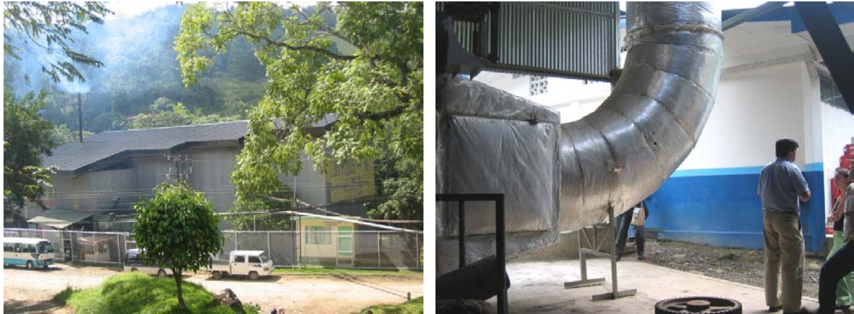
Abbildung 3: Solare Kaffeetrocknung in Coopeldos, Costa Rica, Installierte Leistung: 595 \text{ kW}_{\text{th}} ( 850 \text{ m}^2 Solar Wall Kollektor). Links: Kollektordach, rechts: Warmluftkanal vom Kollektor.
