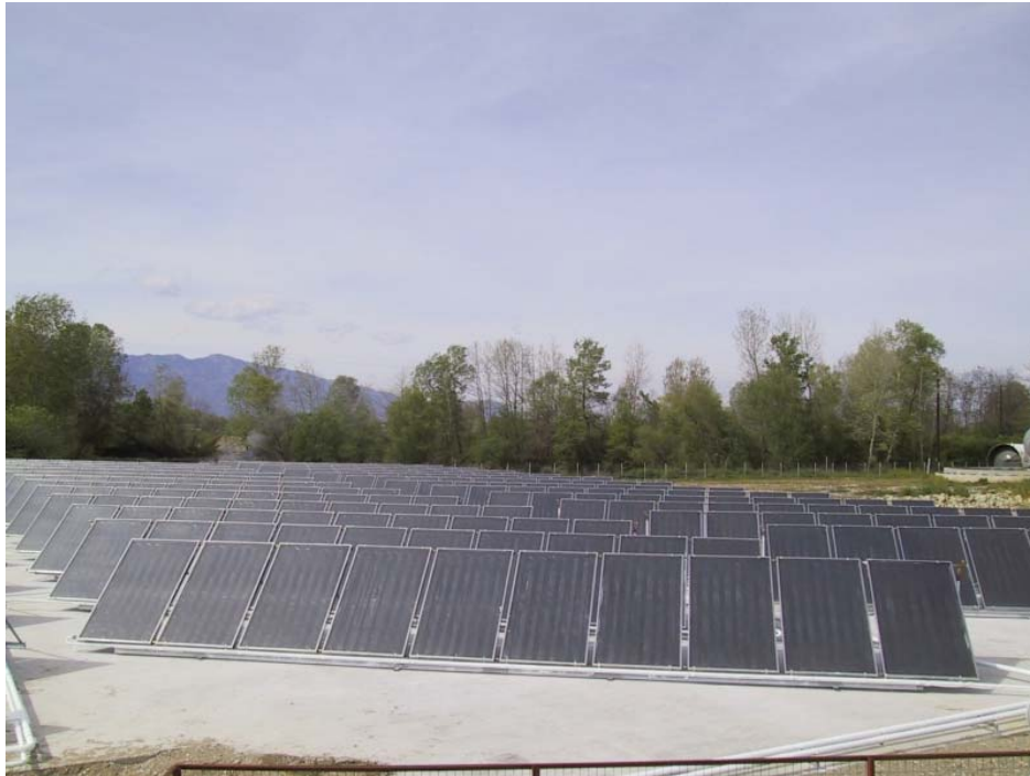
Abbildung 4: Die Solaranlage mit 1040 m 2 versorgt die Waschprozesse der Molkerei Tyras in Trikala, Griechenland
