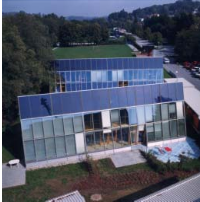
Abbildung 5: Ansicht der beiden Reihenhäuser, die Sonnenkollektoren befinden sich oberhalb des Wintergartens
