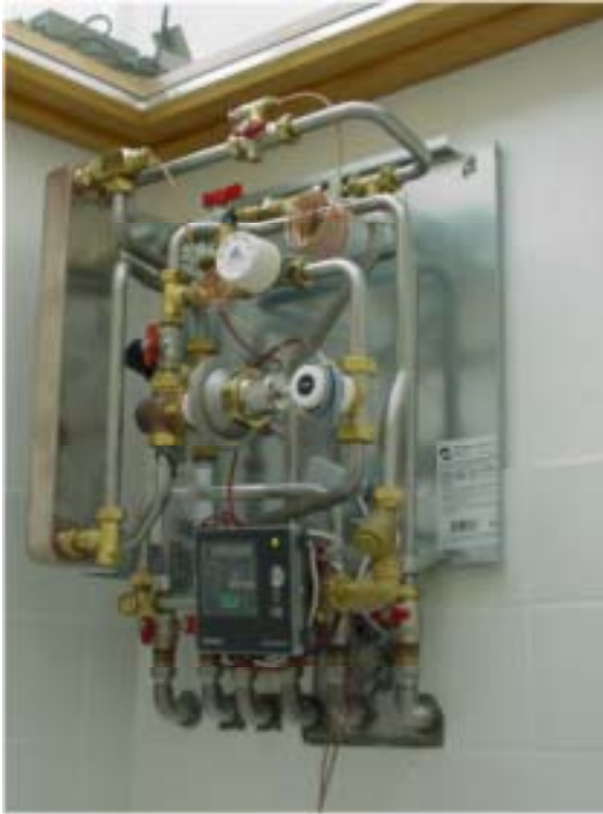
Abbildung 10: Vorinstallierte Wohnungsstation mit externem Wärmetauscher zur Brauchwassererwärmung und sämtlichen Komponenten für den Heizbetrieb inkl. Wärmemengenzähler (Produkt: Gemina-Termix, Bildquelle: GSWB, Salzburg)
