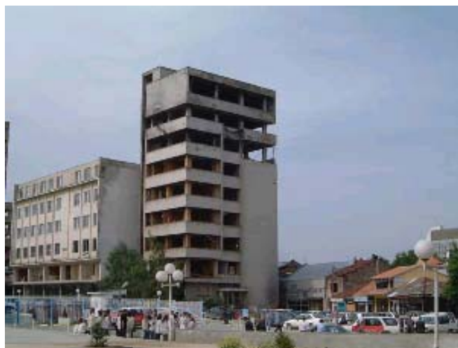
Abb. 1 - EAR-Tower vor Renovierung im Sommer 2002
