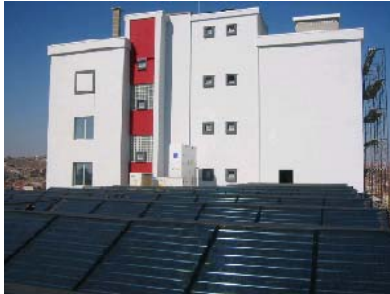
Abb. 4 - EAR-Tower mit Solarkollektoren und Kühlturm
