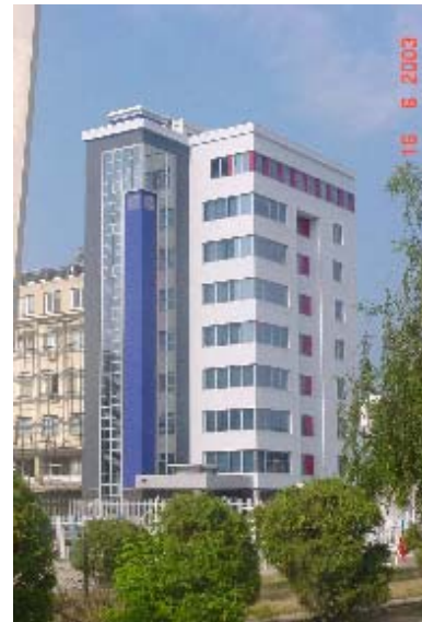
Abb. 2 - EAR-Tower nach Renovierung im Sommer 2003
