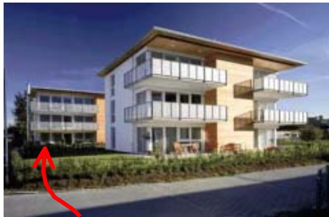
60 kW Pelletkessel 10 m 3 Lager
