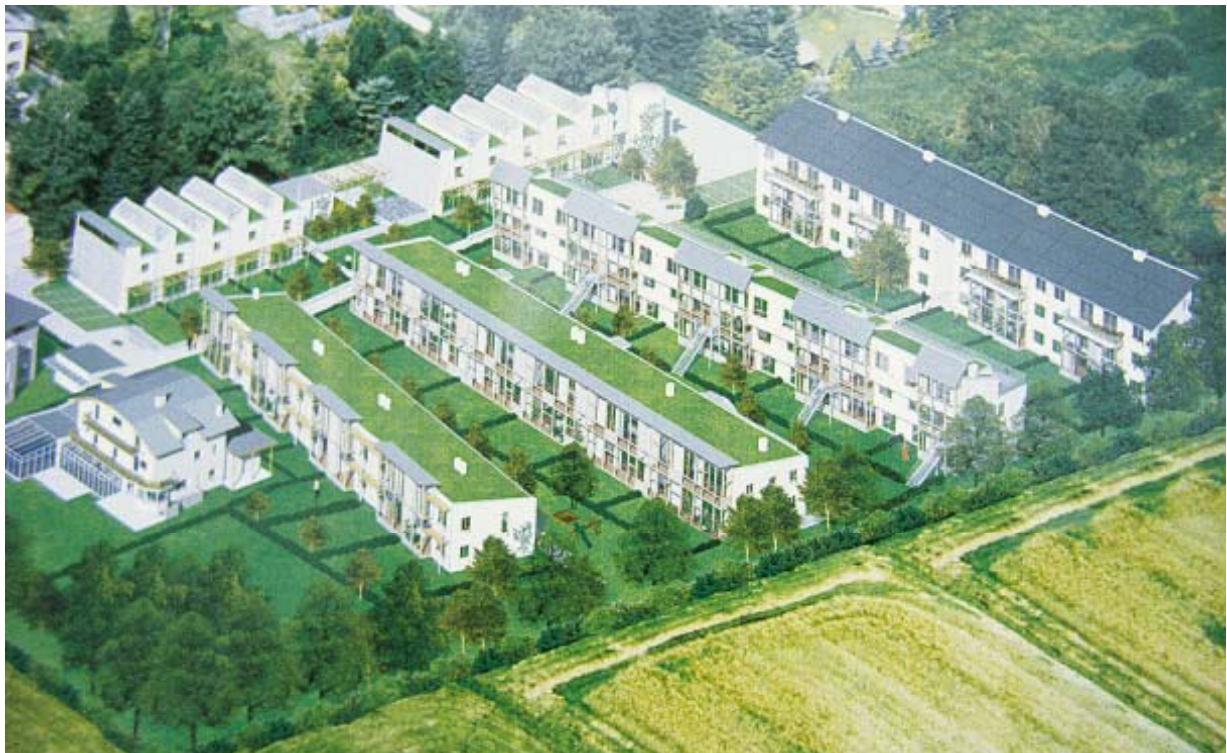
Abb. 2: Solare Kombianlage für Warmwasser und Raumheizung in Salzburg-Gneis-Moos mit 410m 2 Kollektorfläche. Die Anlage deckt rund 35% des jährlichen Wärmebedarfs der 61 Wohnungen
