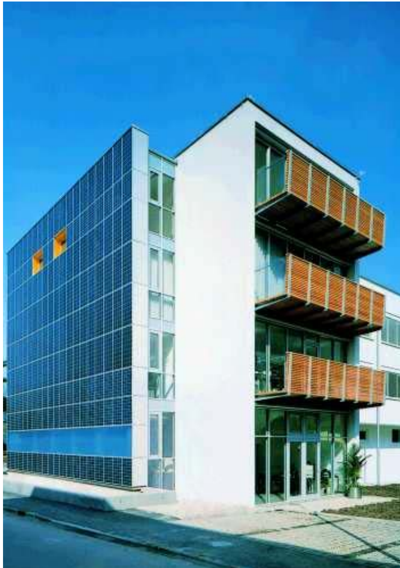
Abb. 10: Photovoltaikanlage Sonnenpark Dornbirn
