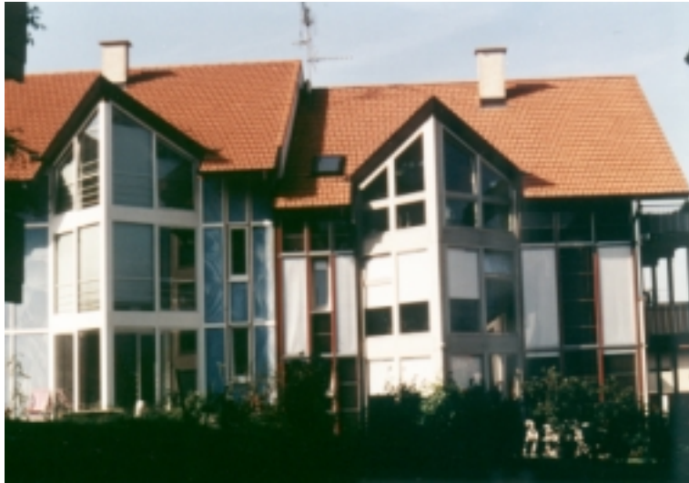
Abb. 21: Reihenhaussiedlung mit TWD Fassade
